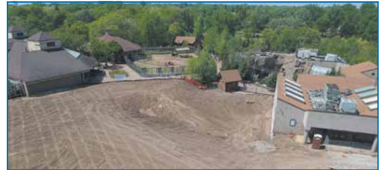
Land cleared for Como Harbor at Como Park. (Photo provided)
